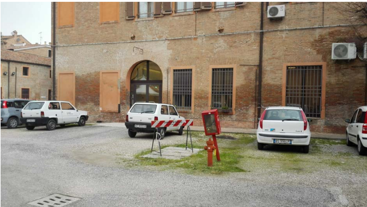
Area di intervento per realizzazione nuovo pozzetto n.2
