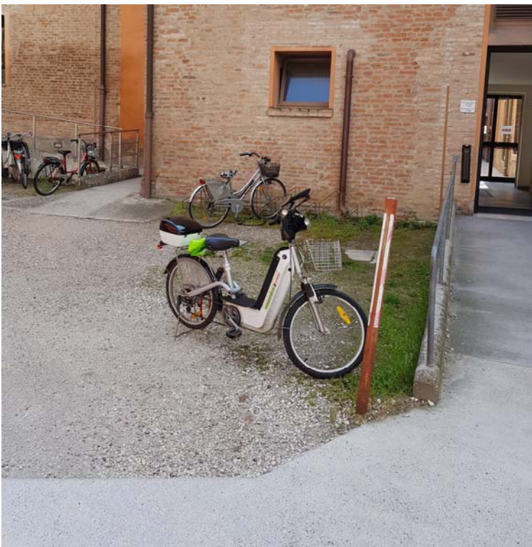
Area di intervento per realizzazione nuovo pozzetto n.1 e spostamento rampa pedonale
